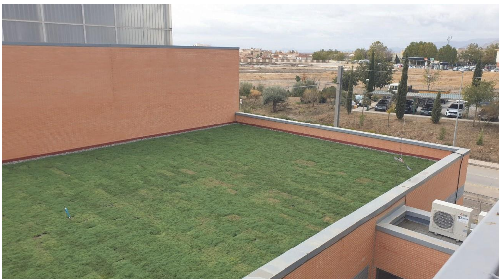
Cubierta verde de Sedum sp. Instalada en las cocheras del Metropolitano de Granada. Noviembre 2022.
